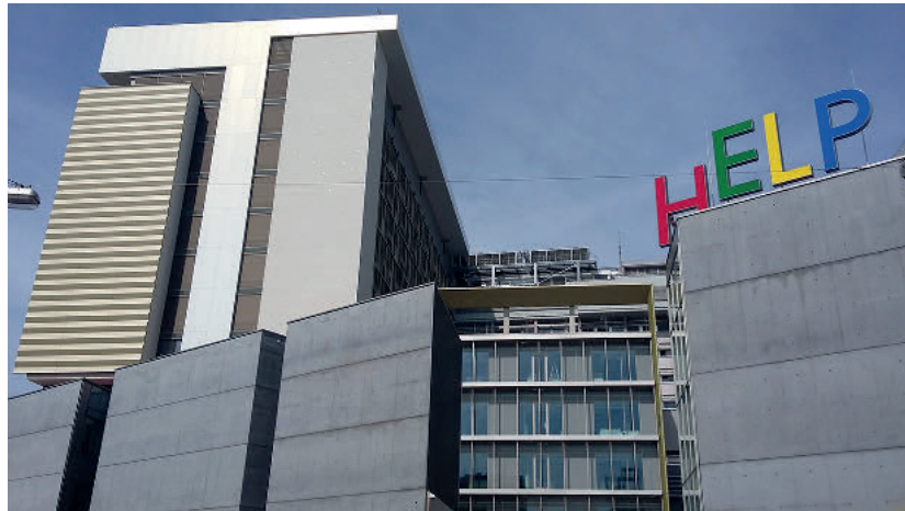
Abb. 2: Hochhaus des Klinikums; © Lorenz Consult
