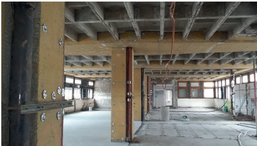
Abb. 3: Untersuchung der vorhandenen Bausubstanz; © Lorenz Consult
